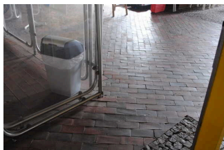
Kassendurchgang zum Bad und Sanitärbereich
